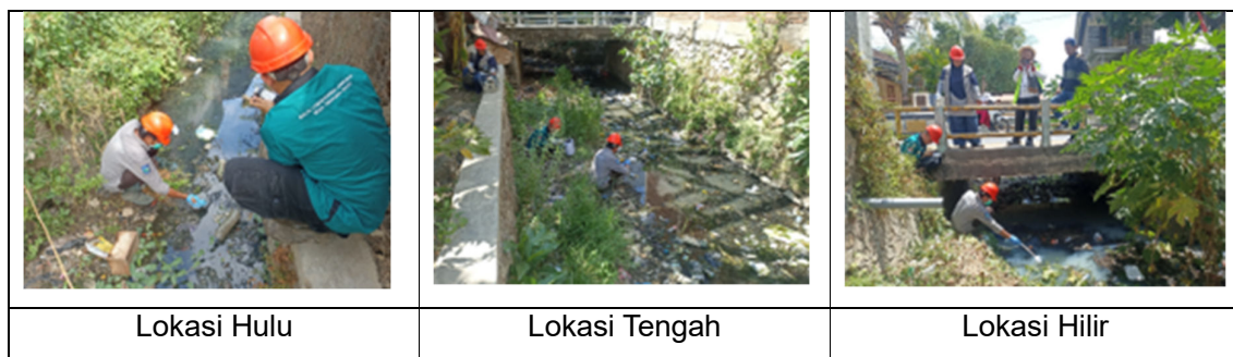
Gambar 3.27 Pengambilan Air Permukaan Drainase Primer Pane-Salama
