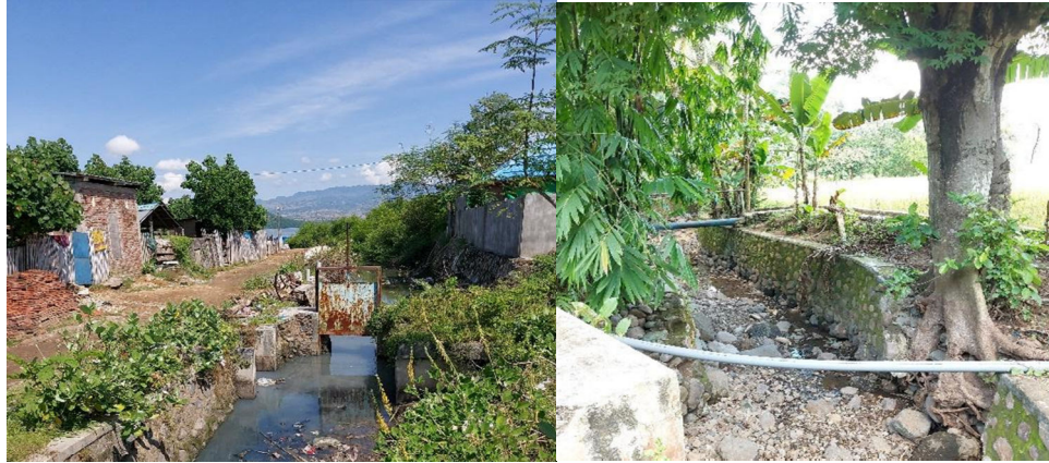
Gambar 1.10 Dokumentasi Drainase Primer Panggi
