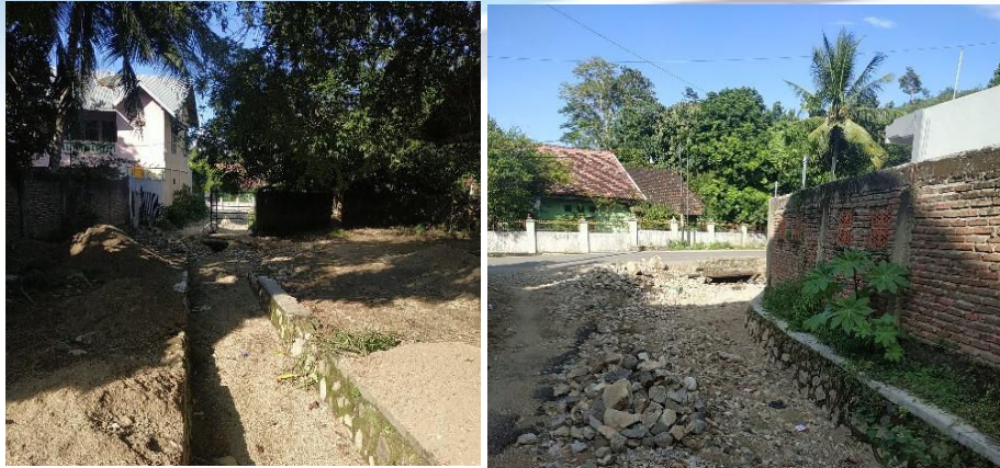
Gambar 1.7 Pendangkalan pada Drainase Primer Sambinae
