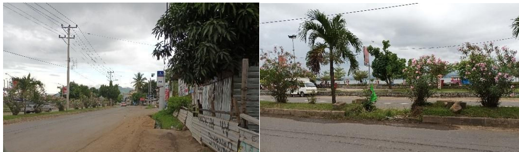
Gambar 1.4 Dokumentasi Drainase Primer Amahami
