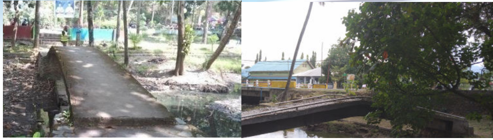
Gambar 1.3 Dokumentasi Drainase Primer Monggonao-Pane-Salama
