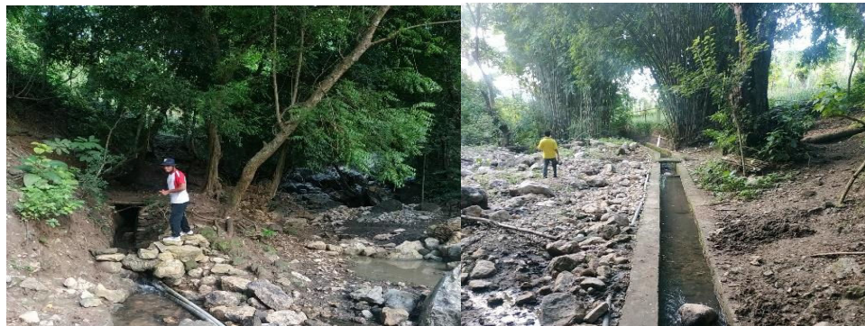
Gambar 1.6: Dokumentasi Drainase Primer Sambinae
