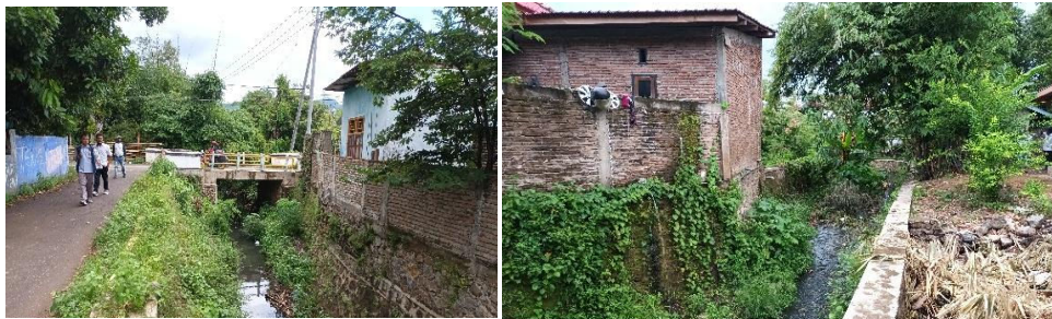
Gambar 1.1 Dokumentasi Drainase Primer Penatoi-Santi
